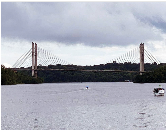
Figura 1 - Ponte Binacional Oiapoque
